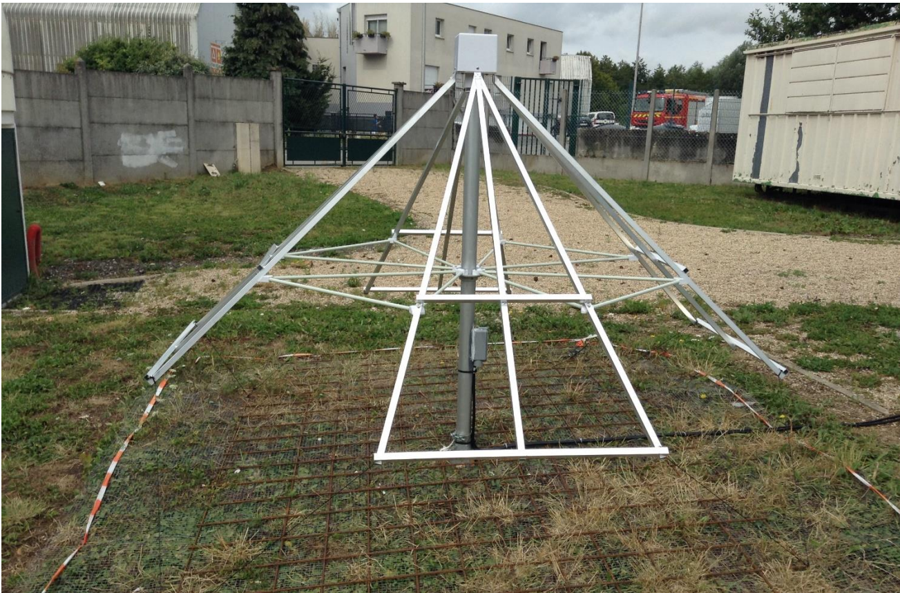
Fin de l'installation. Ajout de haubans pour éviter la rotation sur le plan horizontal en cas de vent
